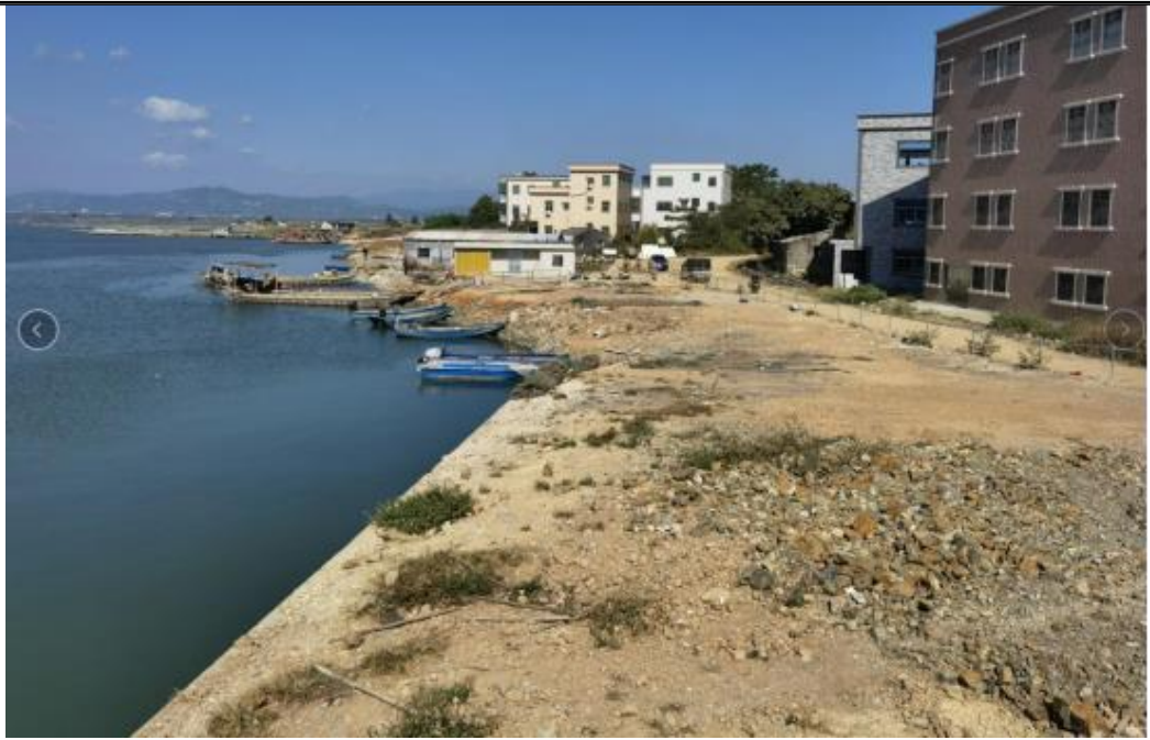
图 3-1 乌坎水闸前河道内围堰养殖及两岸岸线情况
