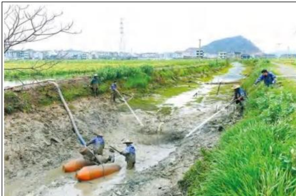
图 2-5 水力冲挖法
